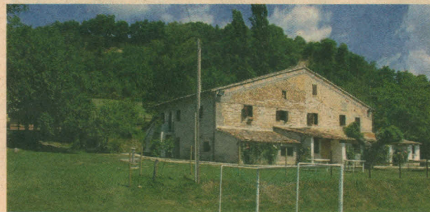
La sede del centro, all'interno della Comunità Montana dell'Alto e Medio Metauro di Urbania
